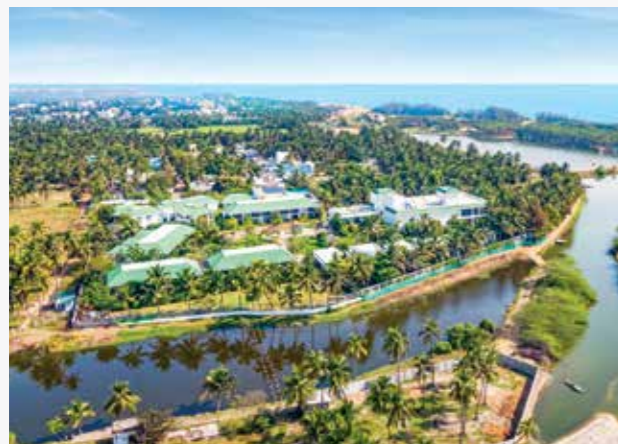
Radisson Resort Pondicherry Bay
